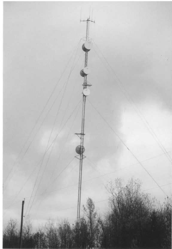
Figure 26. Les tours avec haubans seraient plus résistantes au verglas.
